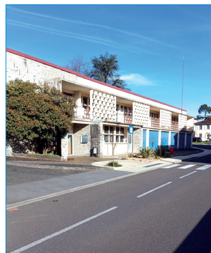
L'ancien bâtiment administratif sera entièrement rénové et réaménagé.
